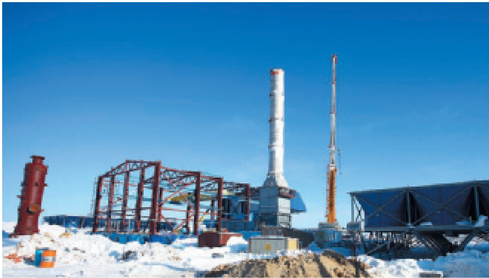
Строительство головной компрессорной станции «Сахалин»
