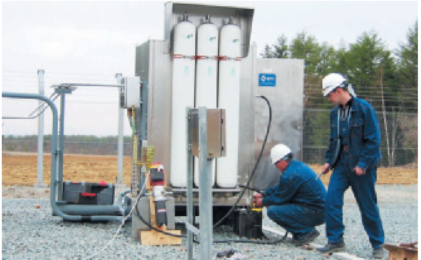
Работа на трассе – привычное дело для сотрудников Инженерно-технического центра
